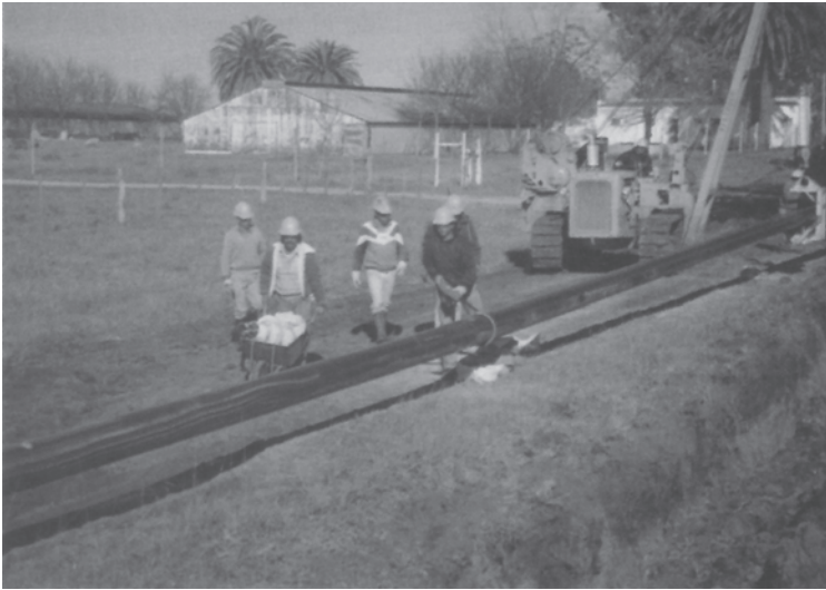
Sistema laboral móvil, trabajo en equipo; tendido de gasoducto
