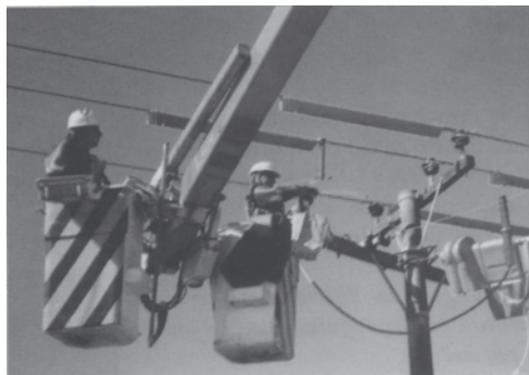
Figura 9.6. Trabajo en equipo (trabajo bajo tensión)
