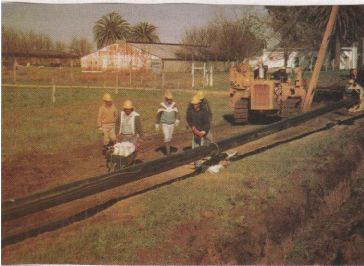
Sistema laboral móvil, trabajo en equipo; tendido de gasoducto
