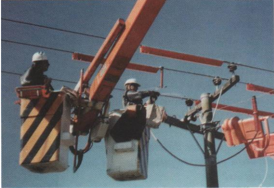
Figura 15.6. Trabajo en equipo (trabajo bajo tensión)
