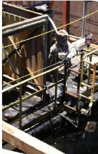
Instalación de mangueras
