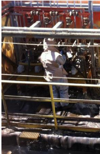
Bloqueo de válvulas
